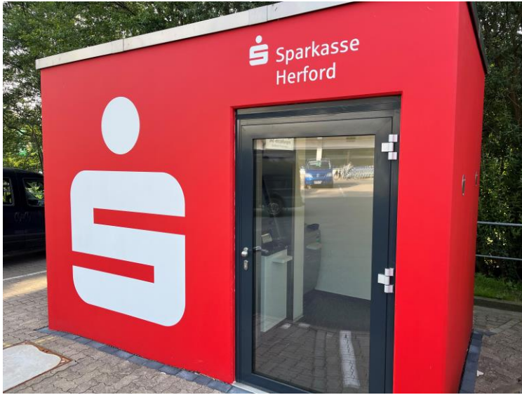
Der neue SB-Pavillon der Sparkasse Herford steht auf dem Rewe-Parkplatz in der Meyra-Straße in Vlotho.
